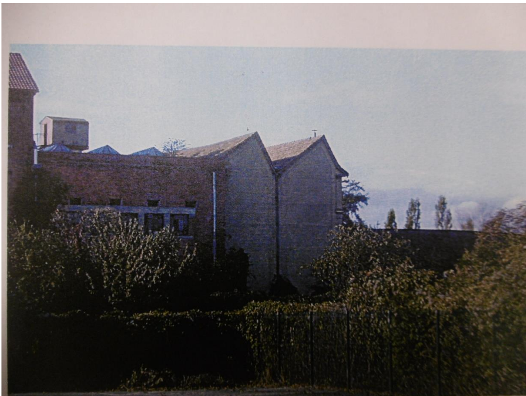
Bâtiment réception de la laine (aujourd'hui démolie pour laisser place à la nouvelle entrée)
