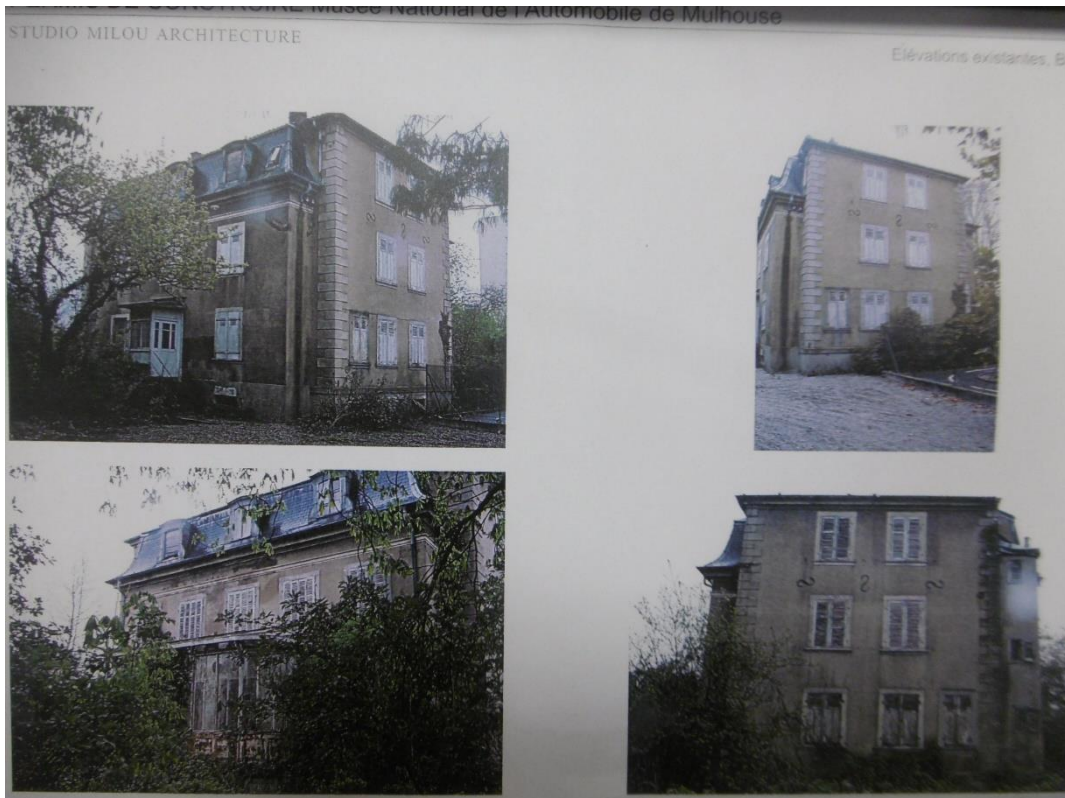
Villa directoriale aujourd'hui démolie
