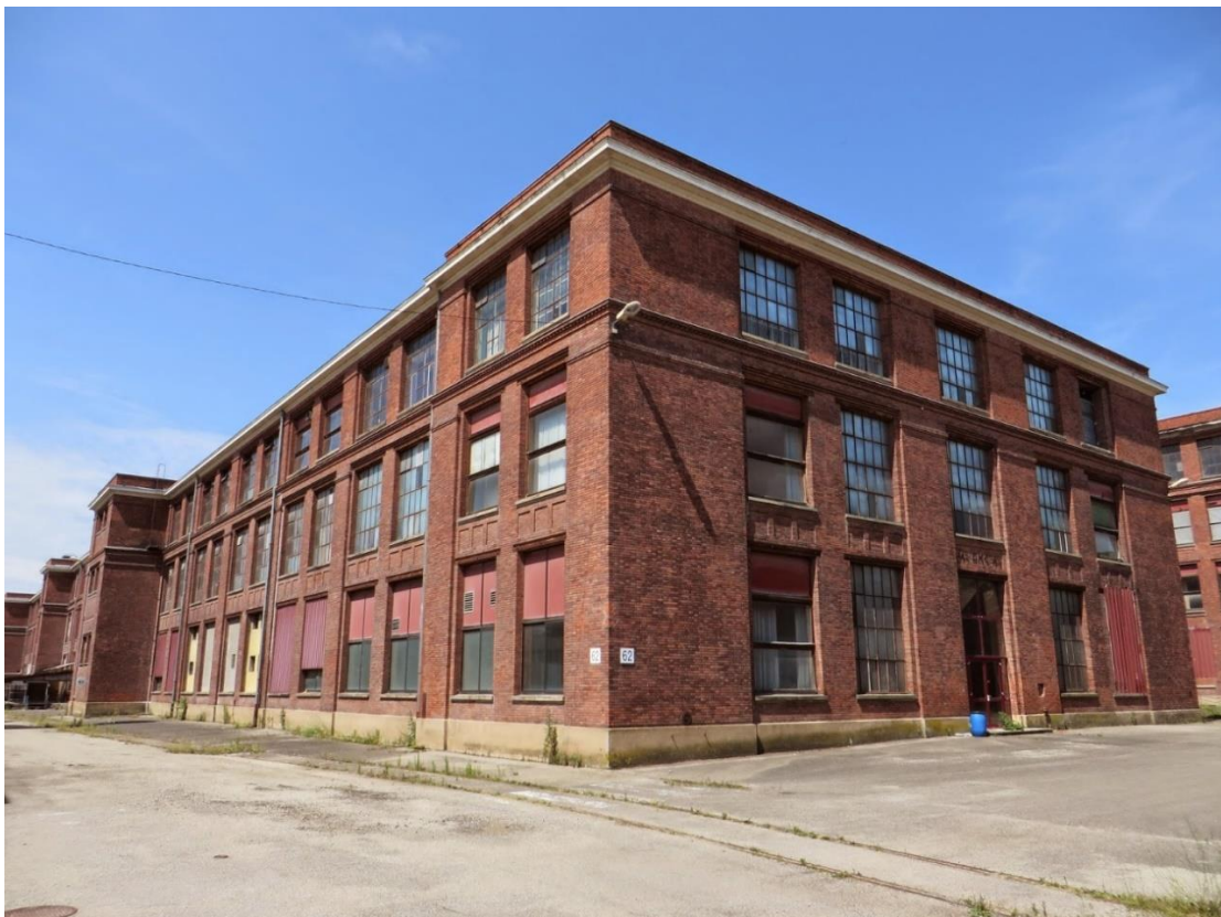
Le bâtiment 62 de 1910 construit pour le retordage (Retordage II)
