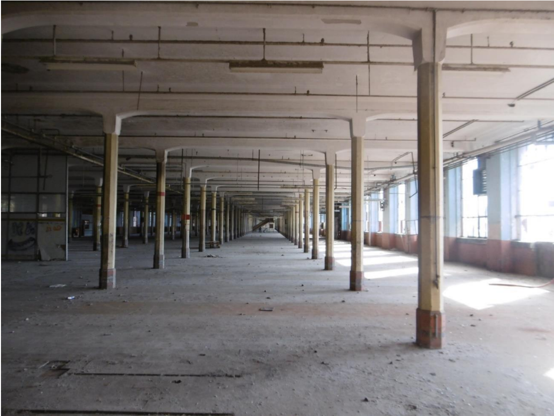
1 er étage du bât. 62
