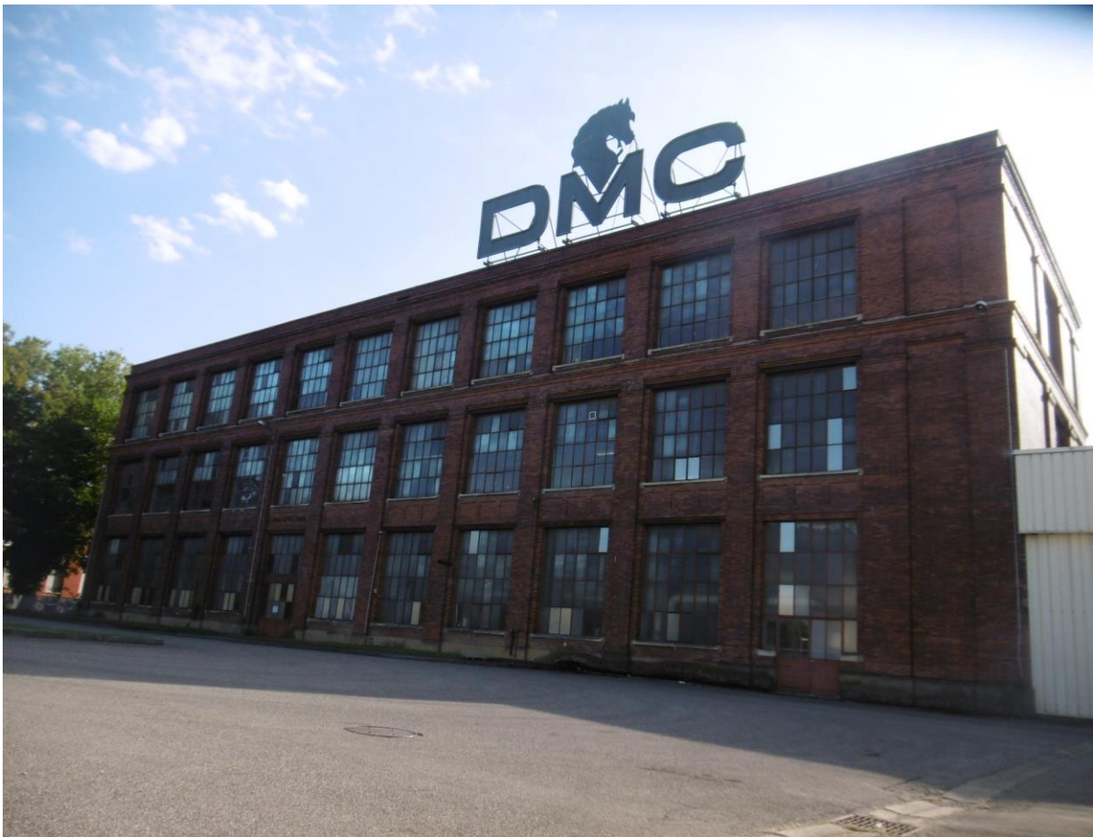
Bâtiment 44 (1902) avec la tête de cheval – Ancien finissage II
